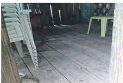
**Piso de madera sin tratar:** se refiere a los cortes de madera que no tienen ningún tratamiento después de su obtención en el corte primario. No están cepillados. No poseen protección contra los insectos ni contra las inclemencias climáticas que las puedan deformar.
