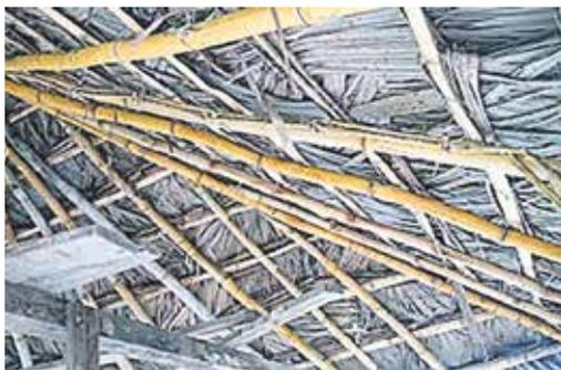
**Estructura caña y madera vista:** son elementos vegetales que según su CORTE se utilizan para realizar una estructura para el soporte de un recubrimiento que protege el interior de la construcción. En este caso, ese recubrimiento es de palma.
