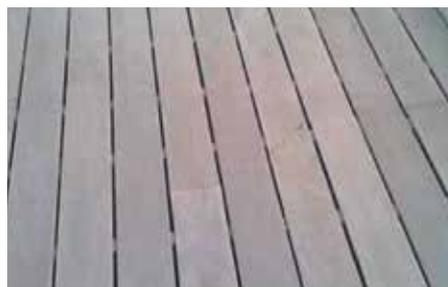
**Piso de madera sin tratar:** se refiere a los cortes de madera que no tienen ningún tratamiento después de su obtención en el corte primario. No están cepillados. No poseen protección contra los insectos ni contra las inclemencias climáticas que las puedan deformar.
