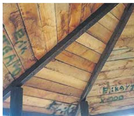
**Madera sin tratar:** se refiere a los cortes de madera que no tienen ningún tratamiento después de su obtención en el corte primario. no están cepillados. no poseen protección contra los insectos ni contra las inclemencias climáticas que las puedan deformar.
