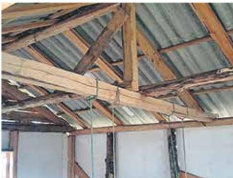
**Estructura madera vista:** son elementos vegetales que según su CORTE se utilizan para realizar una estructura para el soporte de un recubrimiento que protege a la construcción de elementos externos.
