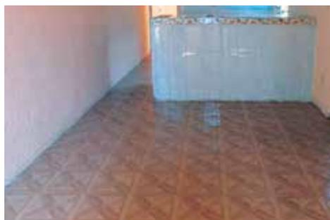
**Piso de vinil:** el suelo de PVC o suelo vinílico es un tipo de revestimiento plástico continuo utilizado en lugares sin excesivo tránsito y que precisan una limpieza frecuente. Está fabricado a partir del Policloruro de vinilo, conocido abreviadamente como PVC.
