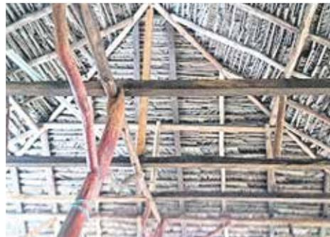
**Estructura caña y madera vista:** son elementos vegetales que según su CORTE se utilizan para realizar una estructura para el soporte de un recubrimiento que protege el interior de la construcción. En este caso, ese recubrimiento es de palma.
