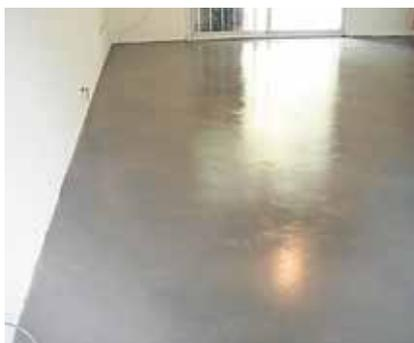
**Piso de cemento:** es una capa de hormigón que se utiliza como mediador entre el terreno natural y el piso. En este caso, definitivo.
